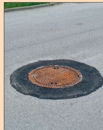
❖ Rekonštrukcia poklopov na Štúrovej ul.
