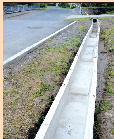
❖ Výstavba odvodňovacieho rigola a rekonštrukcia kovovej konštrukcie mosta na Jesenského ul.
