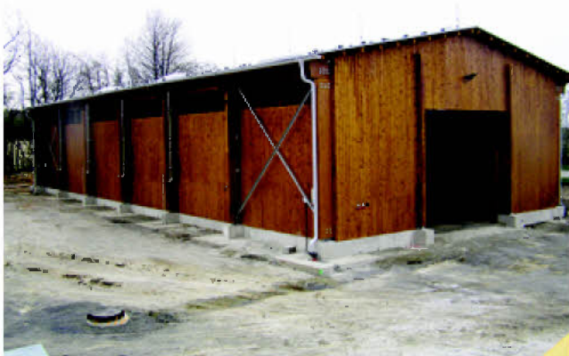
Výstavba dvoch skládok na chemický posypový materiál stála 312 000 €.
