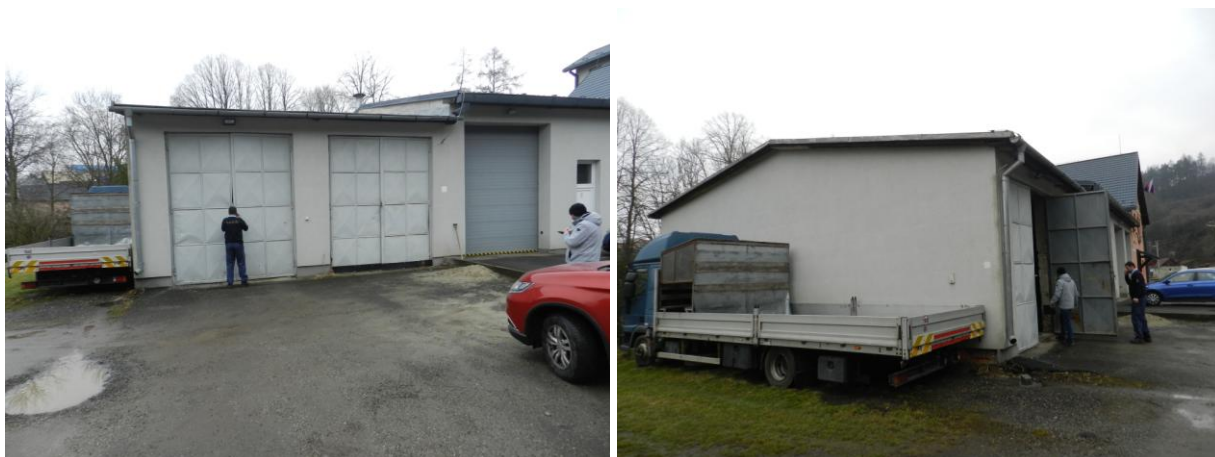
pohľady budova č.s. 532 na parcele KNC 3763/87 v Sp. St. Vsi
