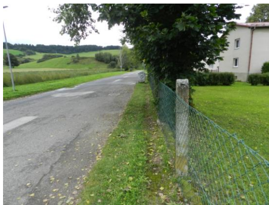
pohľad -prístupová komunikácia KU Sp. St. Ves
